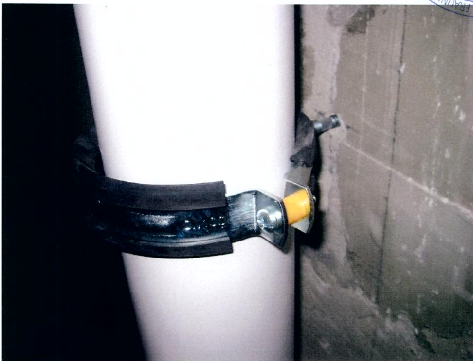
Bild 5 Bild oben: Abwassersystem "CONEL DRAIN" befestigt mit der körperschalldämmenden Stützbefestigung im oberen Wandbereich. Bild unten: Abwassersystem "CONEL DRAIN" befestigt mit einer Führungsschelle im unteren Wandbereich.
